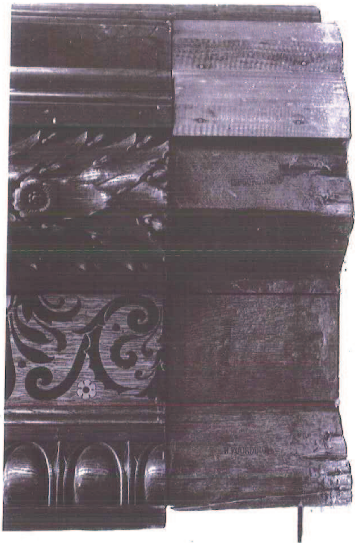
Montant droit du bâti Etat 1980
