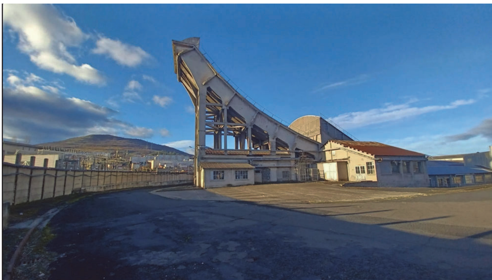
Vue de l'extrémité ouest de bâtiment - Puy de Chanturgue en arrière plan
