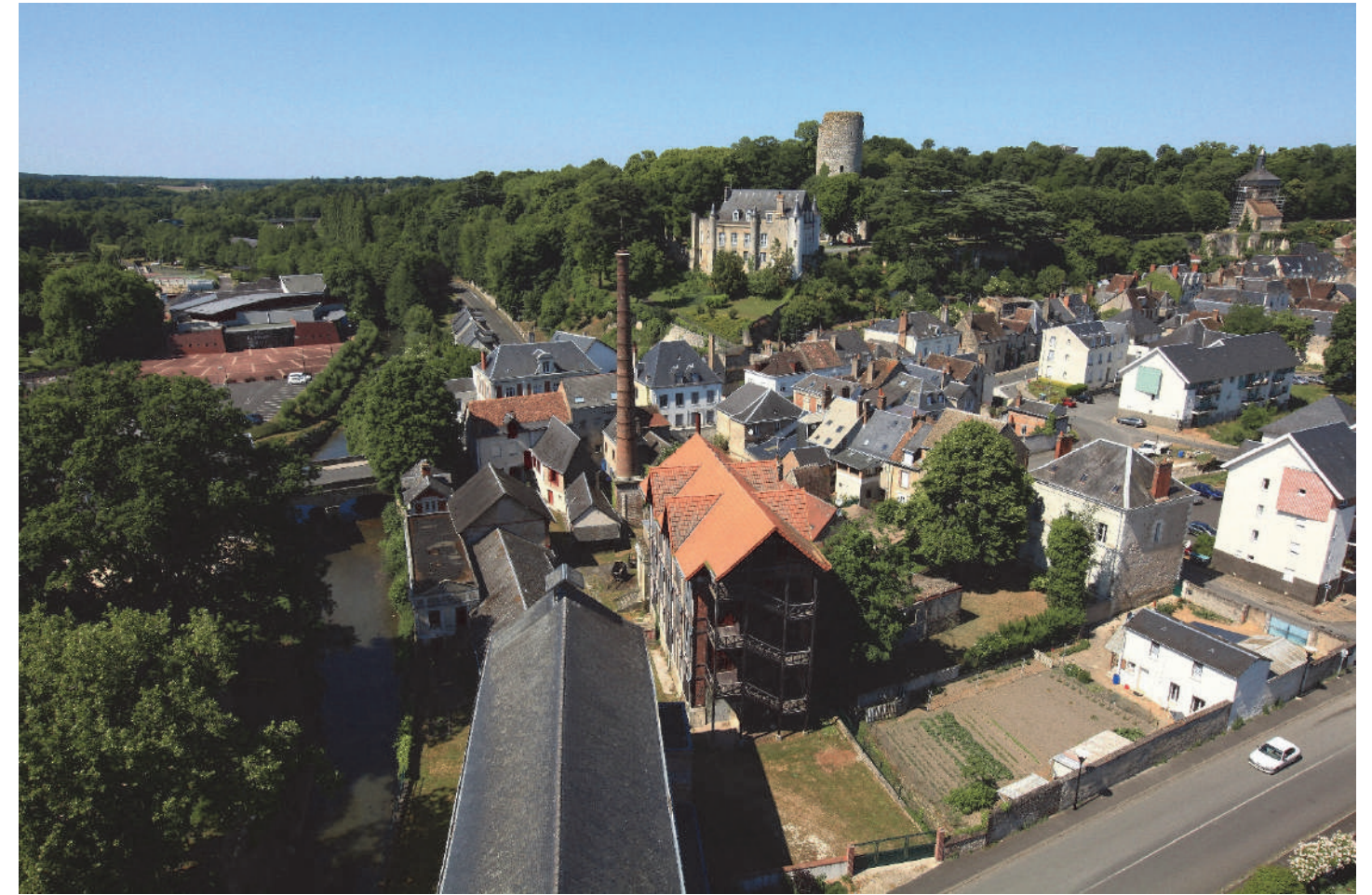
Vue par drone des anciennes tanneries Peltureau-Tenneson depuis le sud
