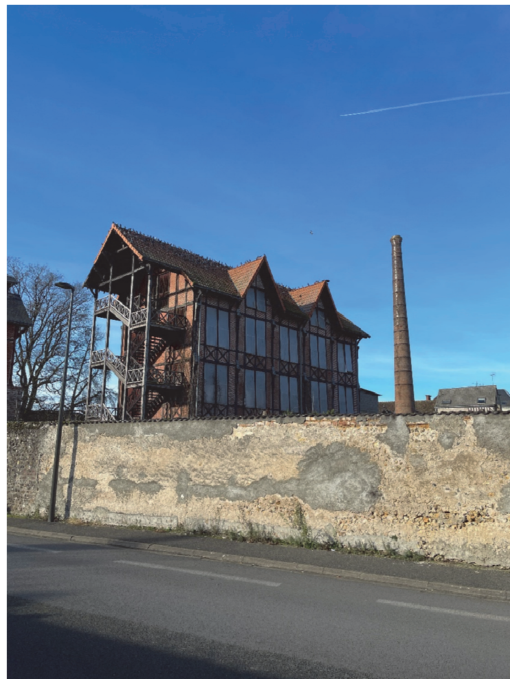
Photographie 4 : façade pignon sud et gouttereau est
