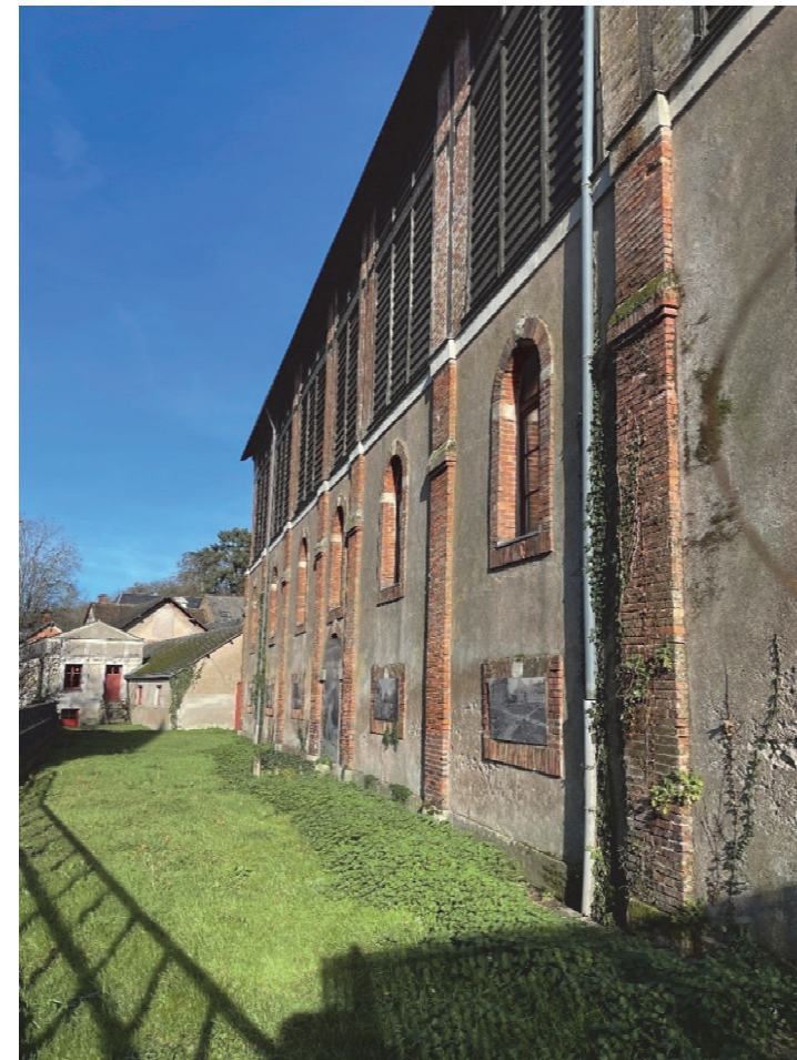
Photographie 8 – gouttereau ouest
