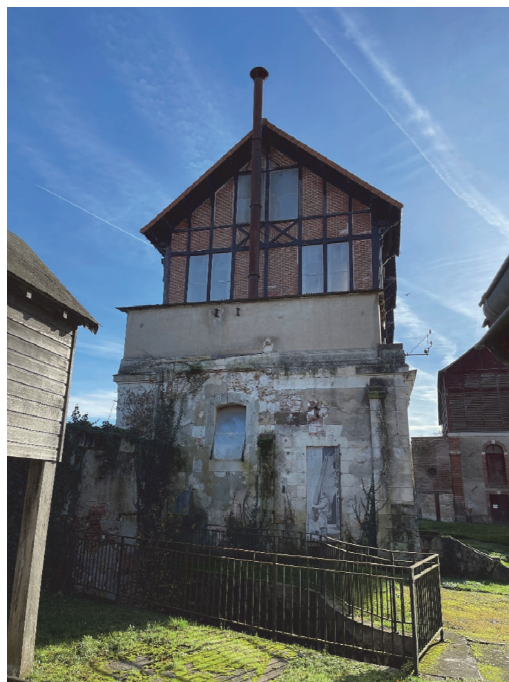
Photographie 6 : façade pignon nord et la salle des machine
