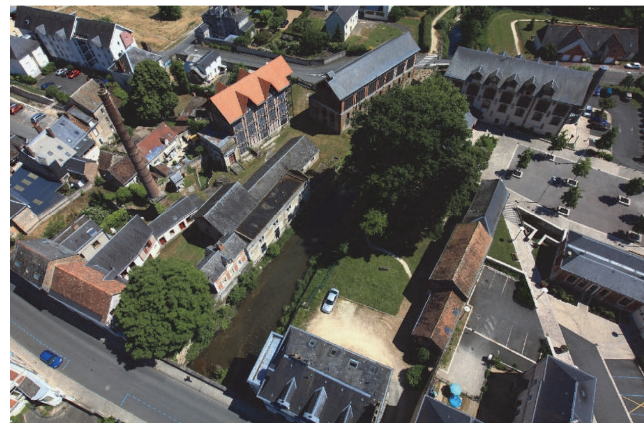
Vue par drone des anciennes tanneries Peltereau-Tenneson depuis le nord
