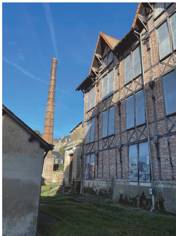
Photographie 5 : façade gouttereau ouest et salle des machines depuis le sud
