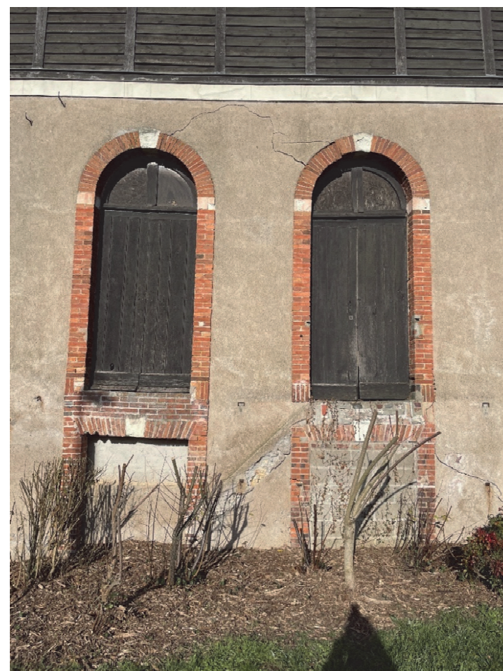
Photographie 7 : rez-de-chaussée du pignon sud
