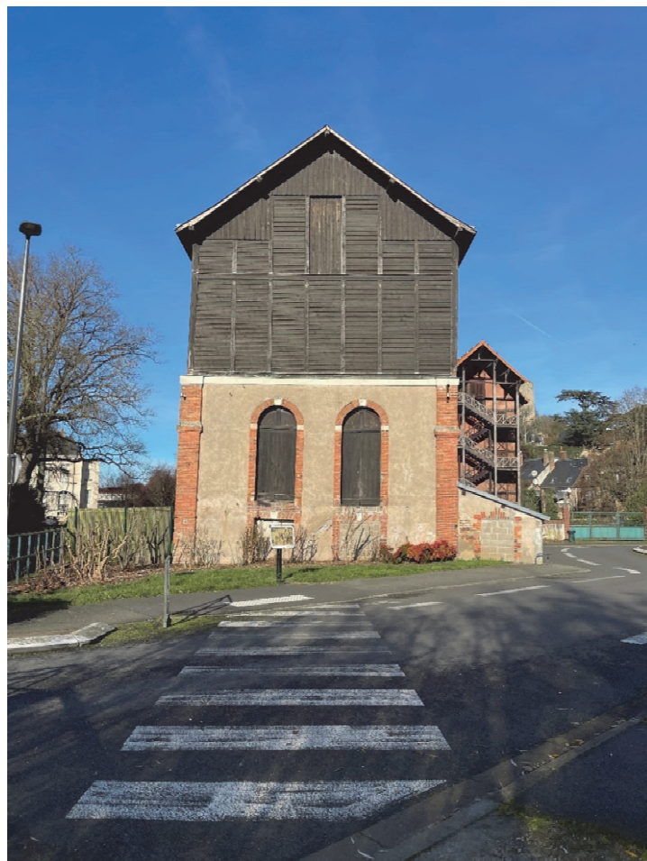
Photographie 3 : pignon sud
