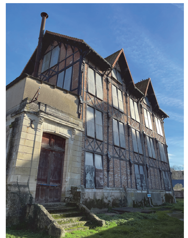
Photographie 7 : façade gouttereau ouest et salle des machines depuis le nord
