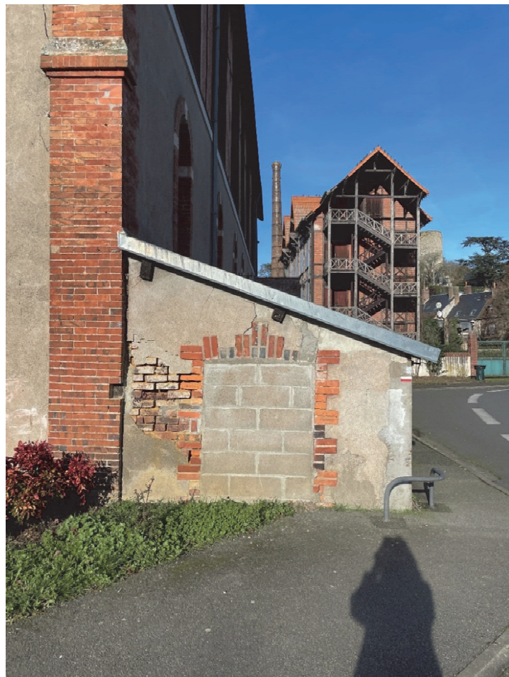
Photographie 6 : pignon sud de la construction en appentis
