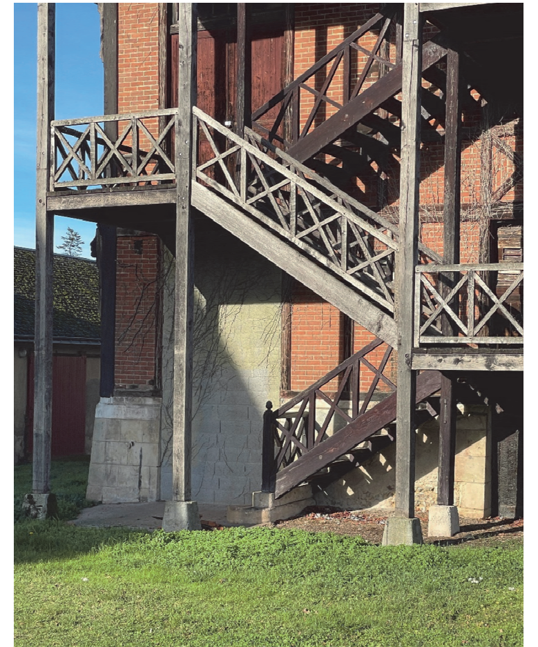
Photographie 3 : rez-de-chaussée du pignon sud
