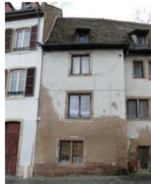
Altération de l'enduit d'une façade en maçonnerie © Bailly-Leblanc
