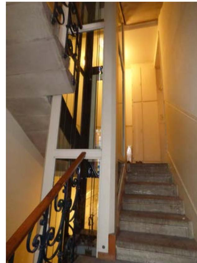
*Implantation d'un ascenseur dans un noyau de cage d'escalier entraînant la réduction du passage, la destruction irréversible des volées en grès et de la main courante © Atelier G. André*
