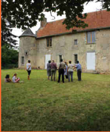
Façade sud de la Grand'Maison
