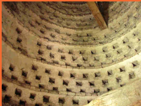
Intérieur du pigeonnier de l'église.
