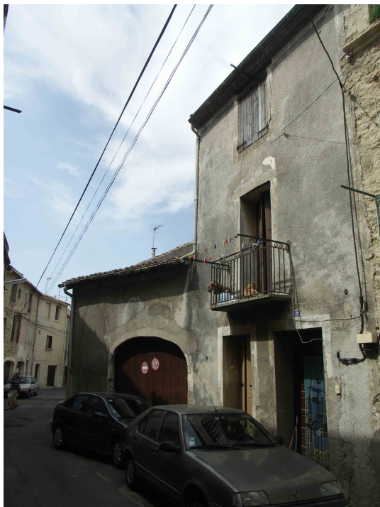
2006 Etat avant travaux
