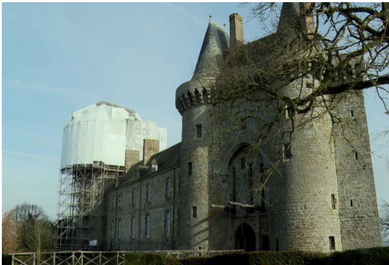
Travaux de charpente sur la tour Duguesclin du château de Montmuran © FTV
