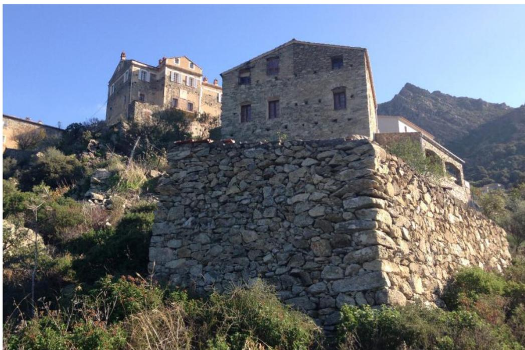
Les murs de soutènement sont traditionnellement en pierres sèches (non maçonnées) afin d'assurer le drainage des eaux de pluie.
