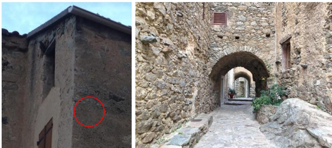
*A gauche, un exemple à Lama d'un trou de boulin comblé avec un enduit à la chaux et marqué d'une étoile. A droite, trous de boulins et pierres d'attente visibles depuis l'espace public à Lama.*
