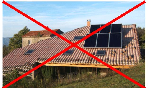
*Les panneaux solaires ne doivent en aucun cas être en console sur la toiture et se présenter comme un «ajout».*
