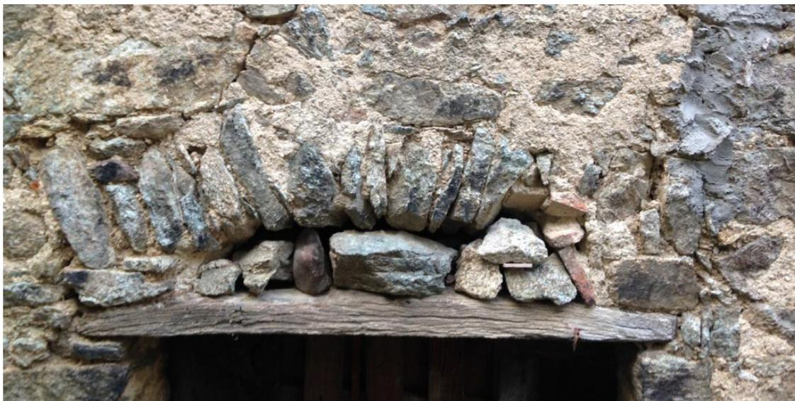
Exemple d'un linteau de fenêtre en bois surmonté d'un arc de décharge en pierre.
