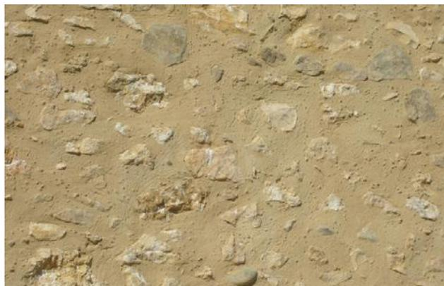
*L'enduit à pierre vue peut être mis en oeuvre pour les mur en moellons de granit.*
