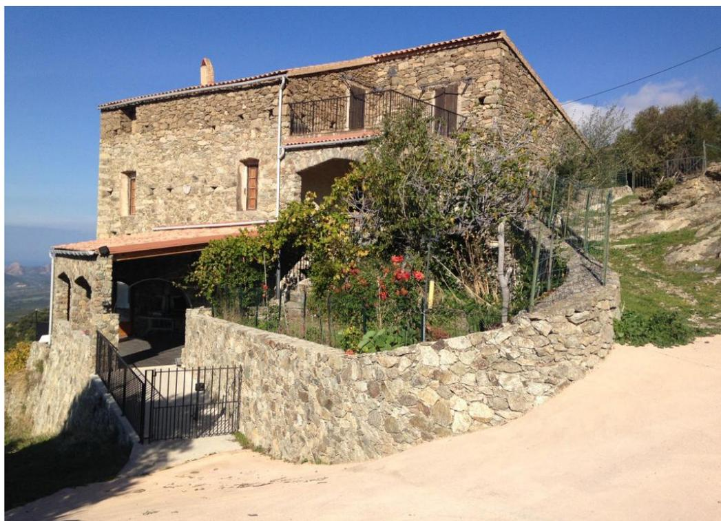
Exemple de clôture respectant les enjeux inhérents au dégagement de vues, à l'inscription dans la pente et à la cohérence de matériaux et de mise en oeuvre avec la construction à laquelle elle se rattache.
