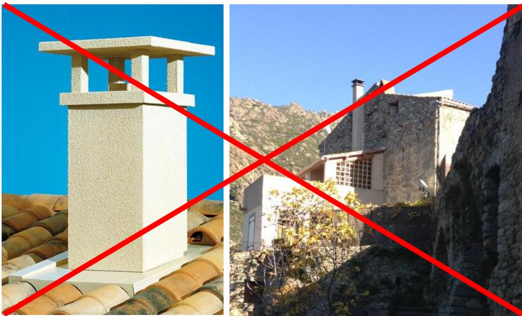
Type de souche (préfabriquée) et conduit de fumée apparent en façade à éviter absolument.
