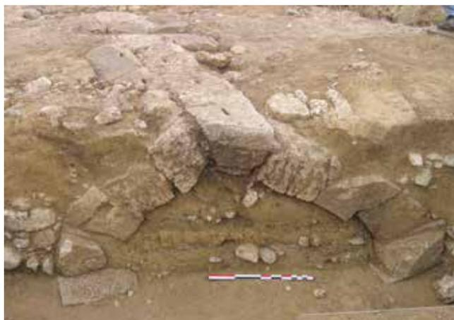
Figure 30 – Pont à arche unique de Réveillon à Narbonne (Aude). L'arc en grand appareil repose sur une fondation de même mise en œuvre.
