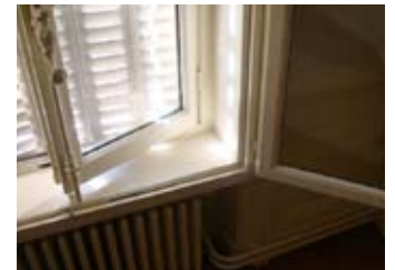
Exemple d'une double-fenêtre qui permet de conserver l'ancienne en l'état. (Hôtel de Sarron à Lyon)
