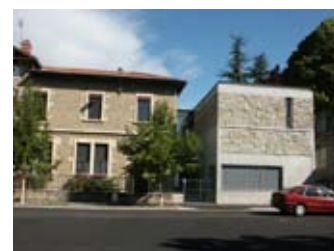
Exemple de l'utilisation de la pierre dans un projet contemporain. Extension de l'école de Saint-Fortunat.
