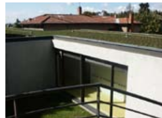
Toiture végétalisée de l'école de Saint-Fortunat.
