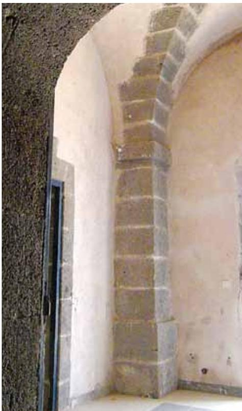
salle des machines (la lanterne jadis équipée d'une lentille de Fresnel a disparu). Les coupes plates appareillées séparant les niveaux de la tour sont traversées par une étroite vis d'escalier. L'architecture, d'une remarquable qualité de mise en œuvre, en est simple, fonctionnelle et solide avec des murs épais, talutés et des structures soulignées en pierre de taille de basalte (corniche, corbeaux, parapet, chaînages et arêtes des voûtes).
