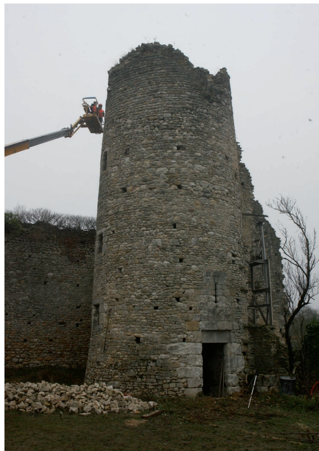
Fig. 2 : La Neuville-sur-Essonnes (Loiret) le château des Deux-Tours : vue générale de la tour d'escalier (C. Lallet, Inrap)
