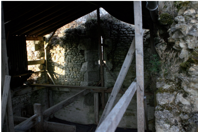
Fig. 1 : La Neuville-sur-Essonnes (Loiret) le château des Deux-Tours : vue générale du mur nord de la chapelle (C. Lallet, Inrap)
