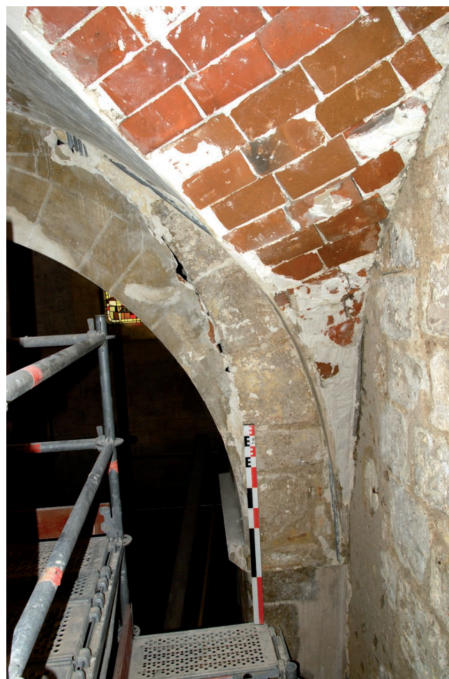
La Chapelle-Saint-Mesmin (Loiret) église Saint-Mesmin : vue de l'angle nord-ouest de la nef au niveau du départ des voûtes en brique et plâtre du XIX e s. À droite, on observe le parement en pierre de taille du mur nord de la nef. À gauche, le départ du doubleau entre le clocher et la nef est visible avec le profil de l'arc en brique et plâtre mis en place lors de la création des voûtes au XIX e s. (S. Bryant, Inrap)
