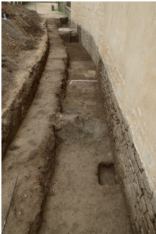
Fig. 1 : Chartres (Eure-et-Loir) cathédrale Notre-Dame, chapelle Saint-Piat : vue vers le sud-est du soubassement du mur de chevet de la chapelle (T. Lacroëre, Direction de l'archéologie de Chartres métropole)
