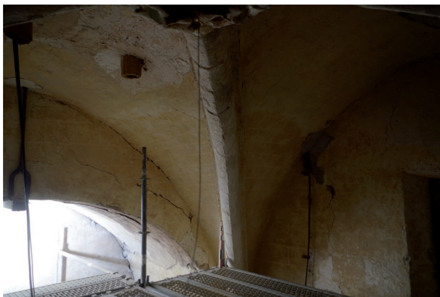
Fig. 2 : Chartres (Eure-et-Loir), église Saint-Pierre : vue vers le sud-est de la voûte du rez-de-chaussée du clocher-porche. À gauche, l'arc triomphal carolingien. À droite, fenêtre de la tour d'escalier (XIII e ). Au centre, la voûte sur croisée d'ogives datée du milieu du XIII e s.
