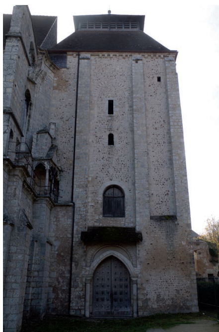
Fig. 1 : Chartres (Eure-et-Loir), église Saint-Pierre : vue vers le sud du clocher-porche de l'abbatiale Saint-Pierre (T. Lacroix, Direction de l'archéologie de Chartres métropole)
