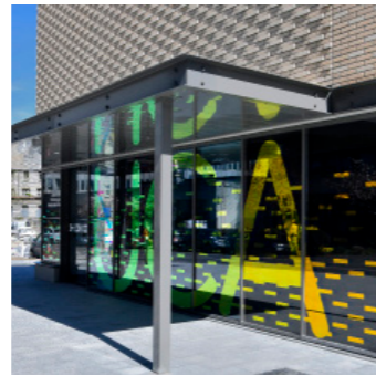
Bâtiment d'Unité de chirurgie ambulatoire La Pitié Salpêtrière, Paris (75) avec TLR architectes
