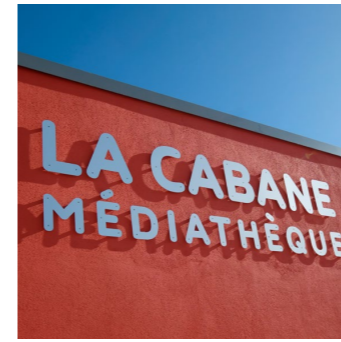
Médiathèque La Cabane, Sainte-Eulalie (33) avec Maryse Axelroux architecte
