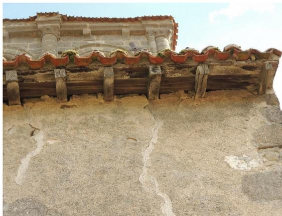
Les contreforts du gouttereau nord de la nef présentent tous un ventre entraîné par le fluage du nucléus sous l'effet de l'écoulement des eaux d'infiltration. Le gonflement est si prononcé qu'il a généré des fissurations importantes.
