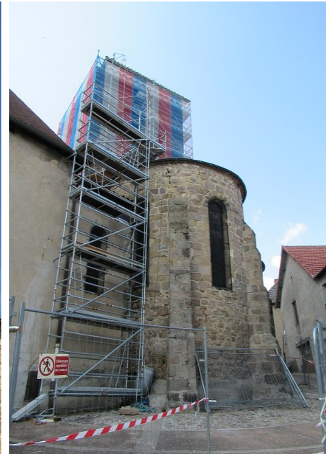
En phase chantier
