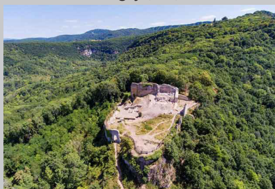
La cour haute du château de St-Germain en cours de fouille, © Buttermilk/Atelier d'archéologie alpine.
