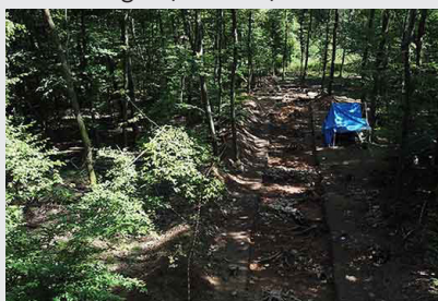
Au milieu des bois, le chantier © A. Nüsslein.
