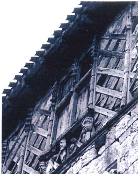
Maison des Têtes : Fenêtre à meneaux bois, Fenêtre à meneaux de pierre transformée à la période classique
