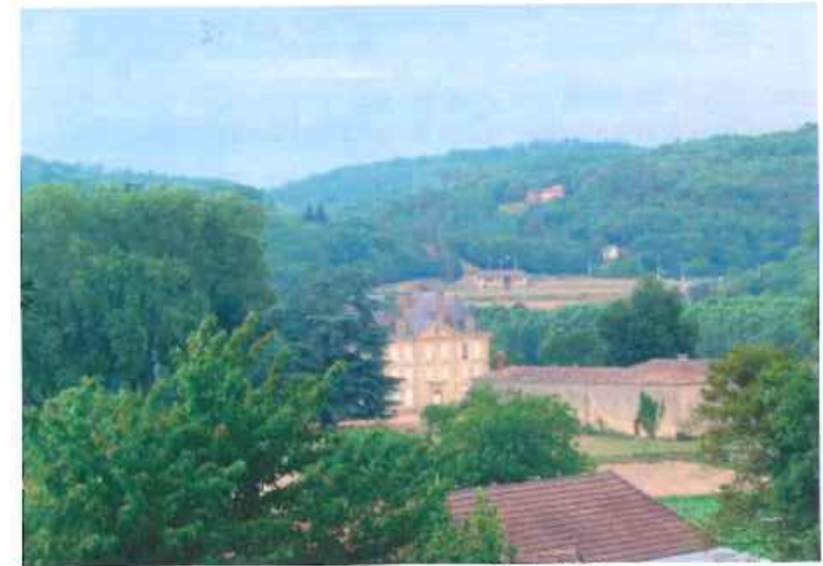
3. Château de Caudon (Caudon - parcelle A 187)
