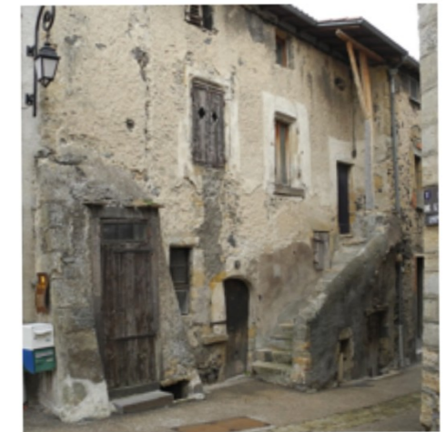
Façade après travaux
