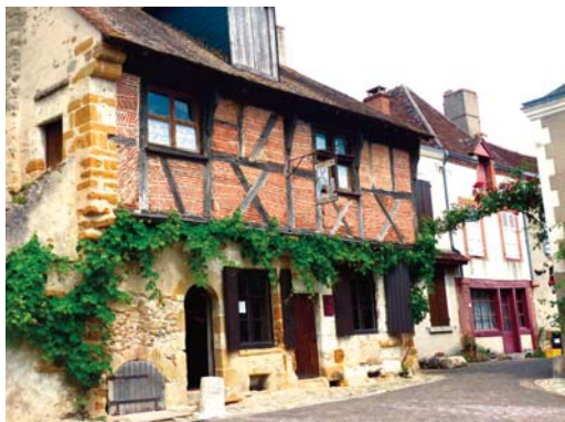
Pan de bois et brique. Cette maison de Mennetou-sur-Cher est typique de l'habitat vernaculaire de Sologne.
