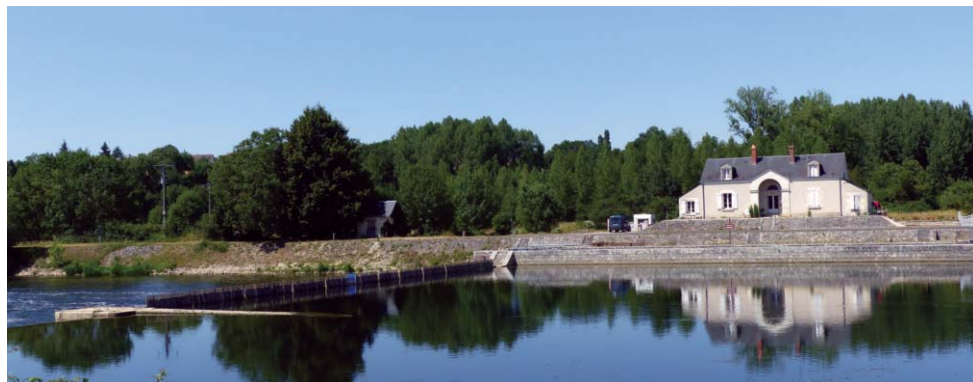
Le Cher canalisé à Saint-Georges-sur-Cher. On peut voir ici tous les aménagements hydrauliques : la retenue d'eau, le barrage à aiguilles, l'écluse et la maison éclusière sur l'autre rive.
