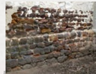
Grès ferrugineux utilisé particulièrement pour la refecton des contreforts et des sousassements à l'époque moderne.
