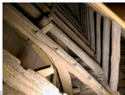
Détail de la charpente de la nef.
