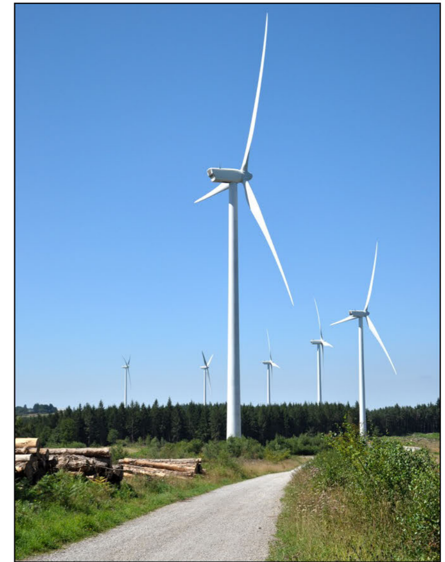
Fig. 24 : Parc éolien de Salles-Curan, Aveyron, Occitanie - Parc onshore - EDF-EN/Cantos et EDF-EN/Ondulia - Vu de 280 m (premier plan) à 1800 m de distance (arrière-plan)
