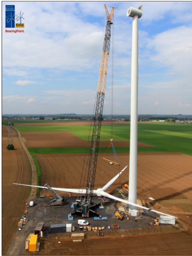
Fig. 9 : Mise en place d'une éolienne (Source : FEE - BearingPoint)
