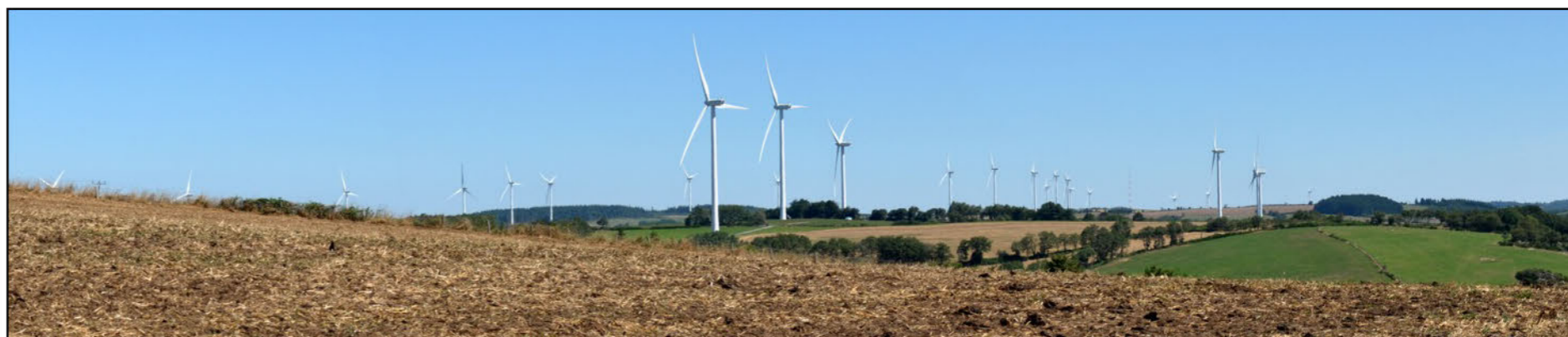
Fig. 29 : Parc éolien de Salles-Curan, Aveyron, Occitanie - Parc onshore - EDF-EN/Cantos et EDF-EN/Ondulia - Vu à 1,8 km de distance.
