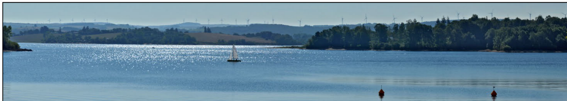
Fig. 30 : Parc éolien de Salles-Curan, Aveyron, Occitanie - Parc onshore - EDF-EN/Cantos et EDF-EN/Ondulia - Vu à 9 km depuis le barrage de Pareloup
