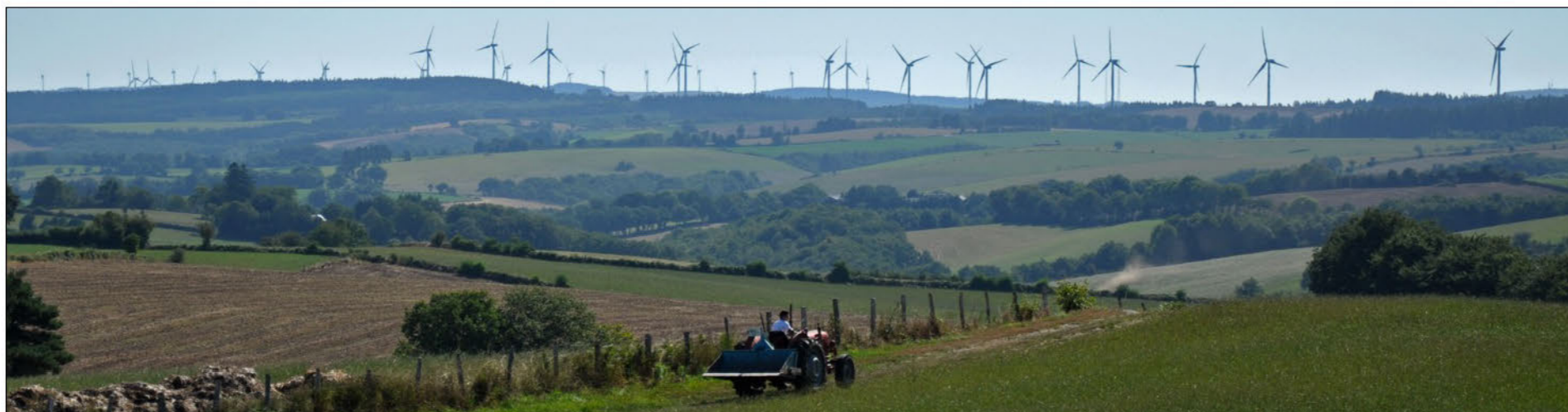
Fig. 42 : Parc éolien de Salles-Curan, Aveyron, Occitanie - Parc onshore - EDF-EN/Cantos et EDF-EN/Ondulia - Vu à 6 km de distance 29 turbines Vestas V90I3000 (3 mW), réparties sur 2 sites - Hauteur : 125 m - Hauteur nacelle : 80 m - Rotor : 90 m - Puissance nominale totale : 87 mW
