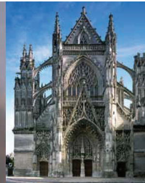
Façade gothique flamboyante de l'abbatiale de la Trinité.
