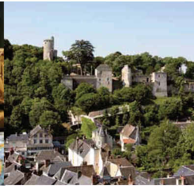
Sur le coteau sud, le château et son parc dominent la ville.
