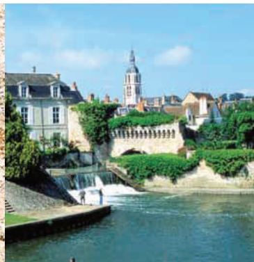
La porte d'eau ou Arche des Grands-Prés qui enjambe le Loir.
