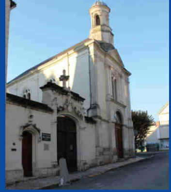
La porte piétonne et le portail de l'hôtel ainsi que l'entrée de la chapelle. Les armoiries du marquis d'Effiat ornent le tympan du portail.
