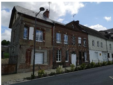
Les constructions du XIX e siècle le long de l'ancienne route de Lisieux
