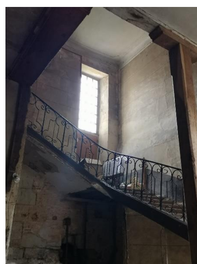
Escalier avec rampe fer forgé dans bâtiment XVIII e - 128 rue Grande
