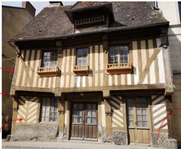
Remplissage en mortier sable et chaux
