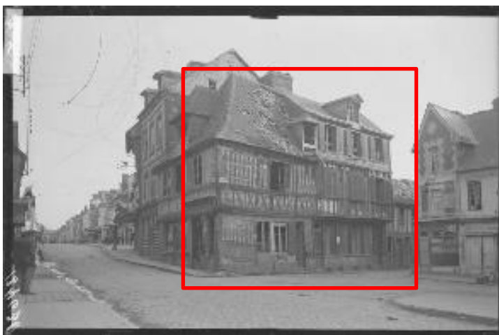
Vieux Manoir et 109 rue Grande après les bombardements
