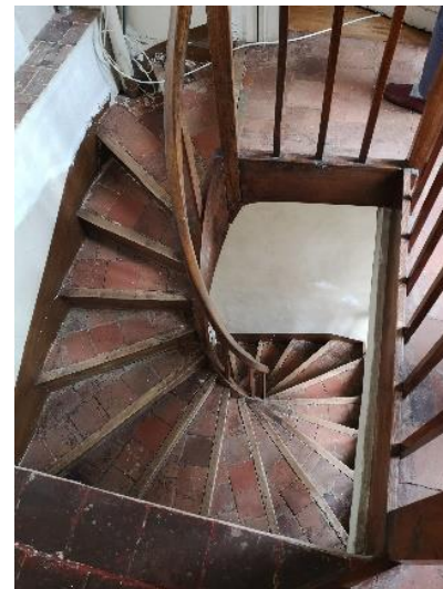
Escalier de service XIX° dans bâtiment XVIII° 128 rue Grande
