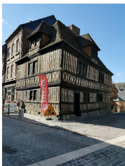
Maison en pans de bois du Vieux Manoir (XVI°) classée le 21.02.1941
