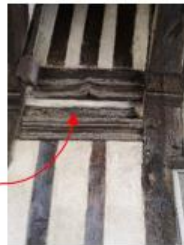
Remplissage en mortier sable et chaux
