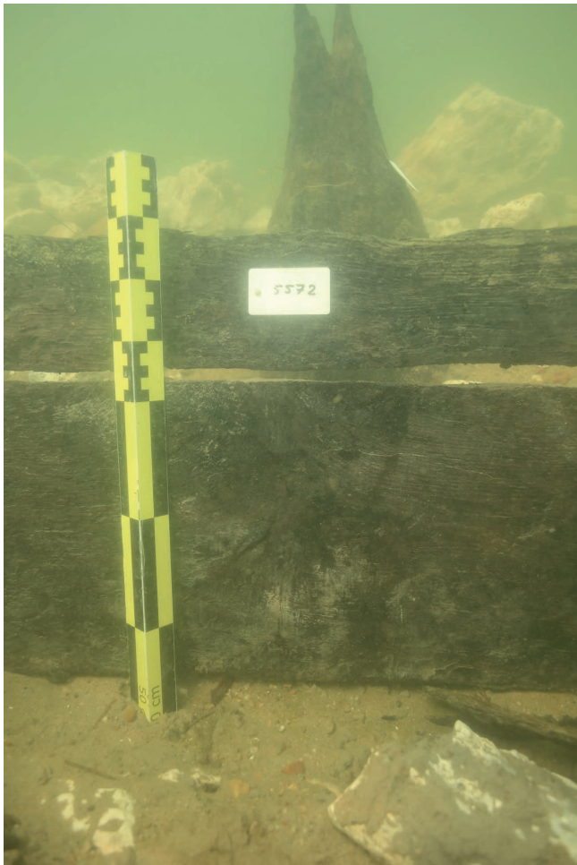
Fig.6 : Blois, lit de la Loire : paroi du caisson de la douzième travée du pont 0162 AH, mire de 0,50 m (PCR Blois)
