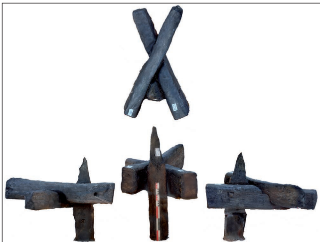
Fig.4 : Blois, lit de la Loire : restitution de l'assemblage de l'arrière-bec de la structure 40, les trois pièces de bois étant maintenues par une cheville de bois, mire de 0,50 m (PCR Blois)
