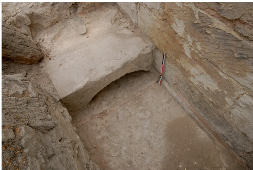
Châtillon-sur-Indre (Indre) Logis Pierre de la Brosse : une partie du sol du chemin de ronde. Le soffite de la dalle est échancré et forme un drain pour diriger les eaux pluviales vers une gargouille intégrée dans l'encorbellement soutenant le chemin de ronde (Simon Bryant, Inrap)
