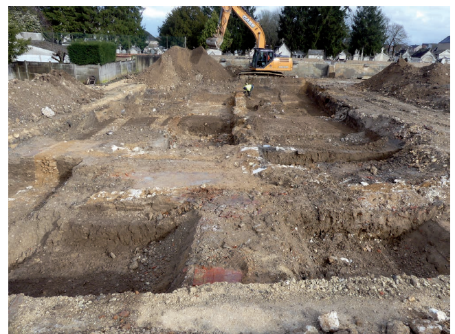
Fig. 1 : Bourges (Cher) 33 rue Émile-Martin : un ensemble bâti complexe au décapage correspondant pour partie au Couvent des Capucins (Bourges Plus)
