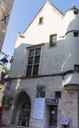
Maison des États généraux, façade sur rue
