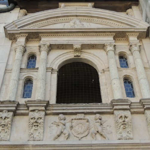
La travée centrale du cabinet de l'hôtel Sancier, occupée par une baie en plein-cintre, est encadrée de deux travées plus étroites.
