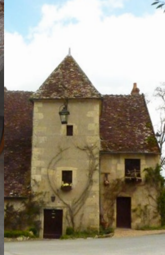
Maison des Mariniers en pierre calcaire d'Apremont
