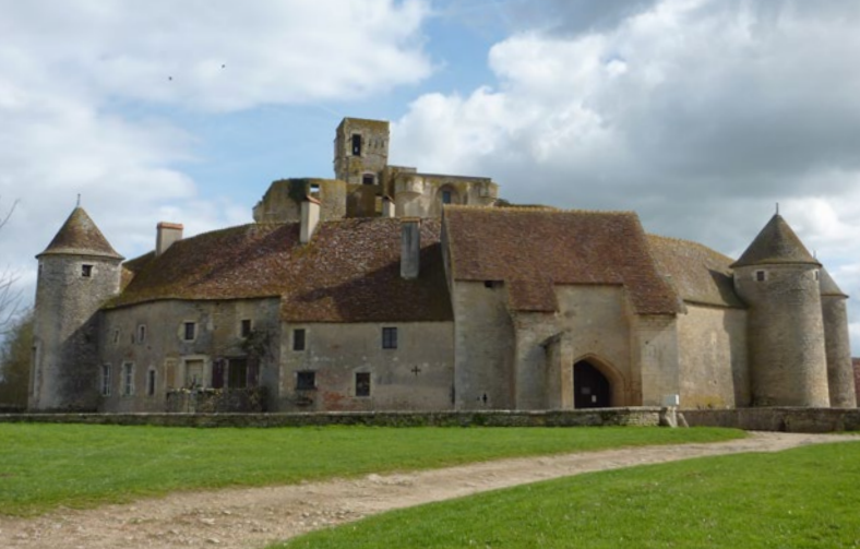
La forteresse de Sagonne conserve, dans la Tour dite de l'Horloge, une chapelle créée par Jules Hardouin-Mansart et décorée de peintures murales en trompe-l'œil
