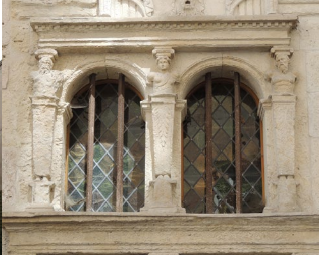
Sur la façade de la maison de la Coquille, trois termes délimitent les deux jours d'imposte de la porte d'entrée et supportent un entablement
