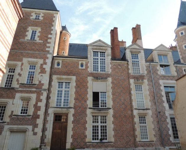
À chaque extrémité de la façade sur cour du corps principal de l'hôtel de la Vieille-Intendance, une grande tour hors-œuvre abrite un escalier en vis
