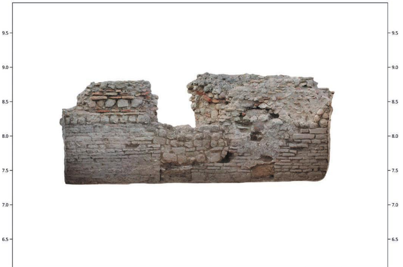
Fig. 9 – Bonifacio, Piantarella : vue frontale du mur de cloison entre les pièces A8 et A11 (M. Seguin, DRAC de Corse).
