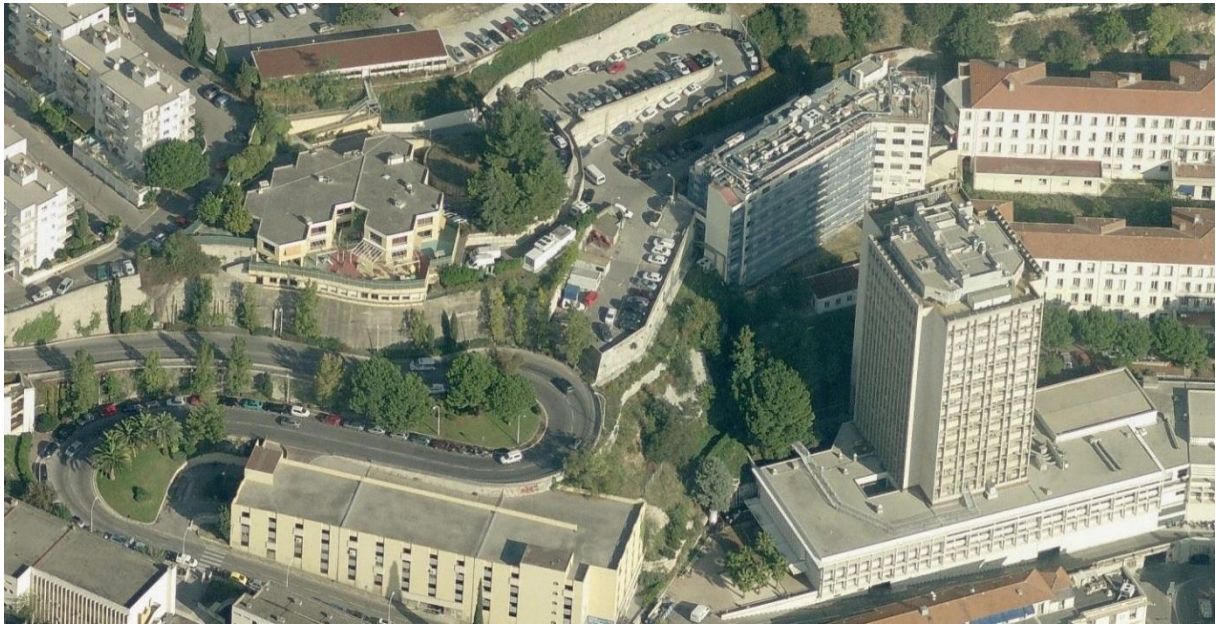
Le bâtiment K est celui prenant la forme d'alvéoles hexagonales (en haut à gauche). Source BING MAPS.
