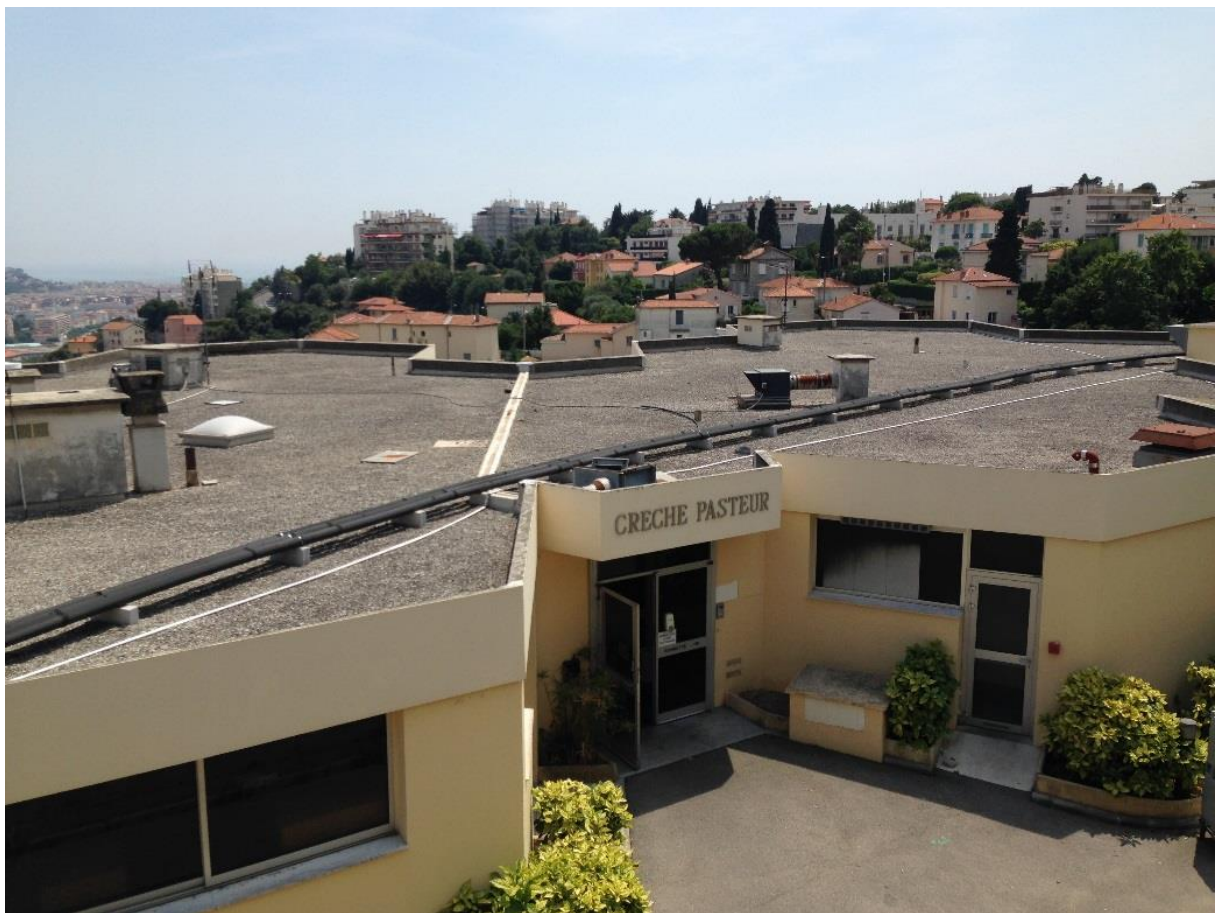
Vue depuis la façade Nord du bâtiment K.
