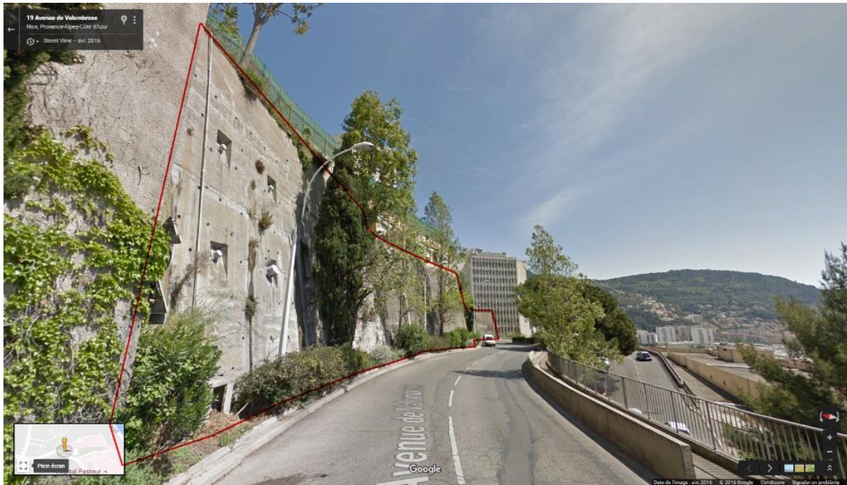
Vue depuis l'Avenue de Valombrose du mur de parement/soutènement (rouge), avec la tour du campus Pasteur au second plan. Source Google Street view.
