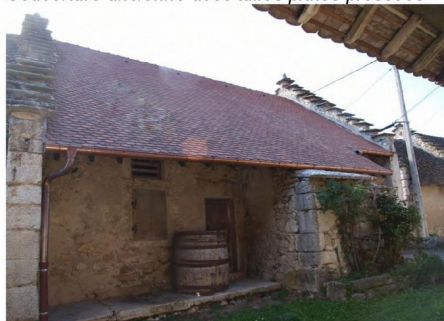
Couverture ancienne avec tuiles plates pressées
