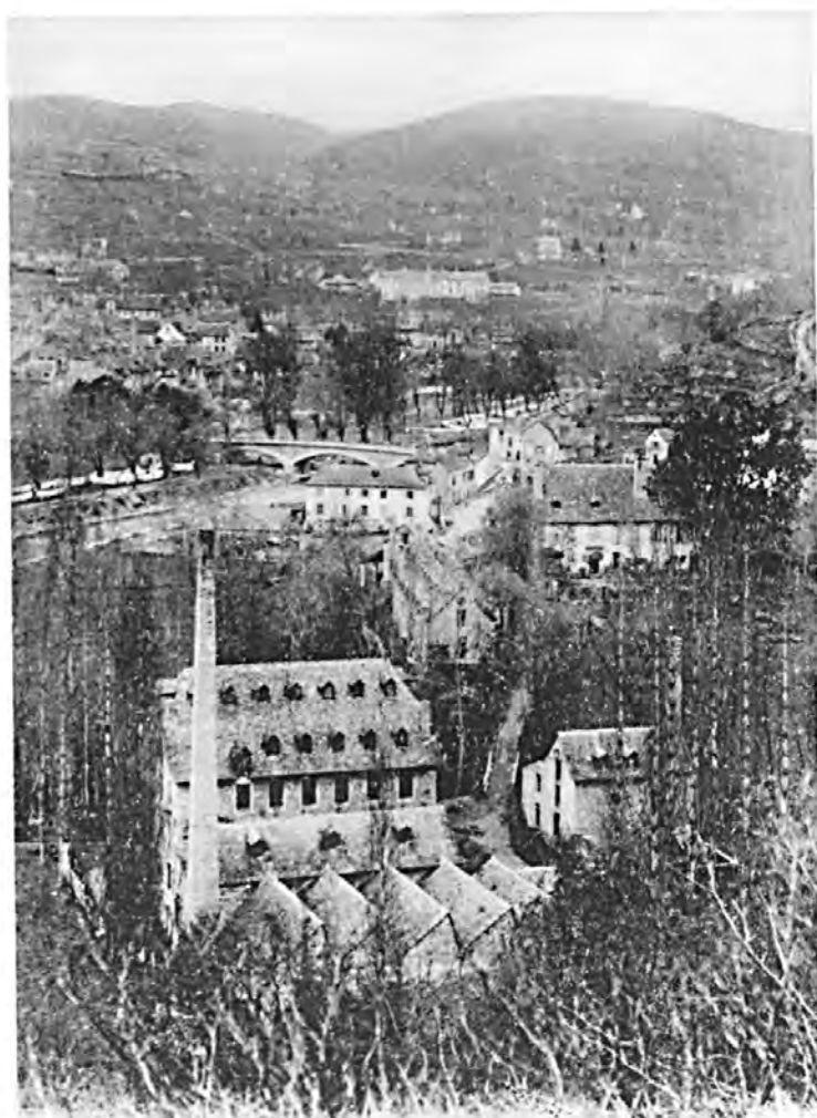
USINE DE LA GOUTELLE, MARVEJOLS, DÉPARTEMENT DE LOZÈRE (CANTON DE MARVEJOLS)
