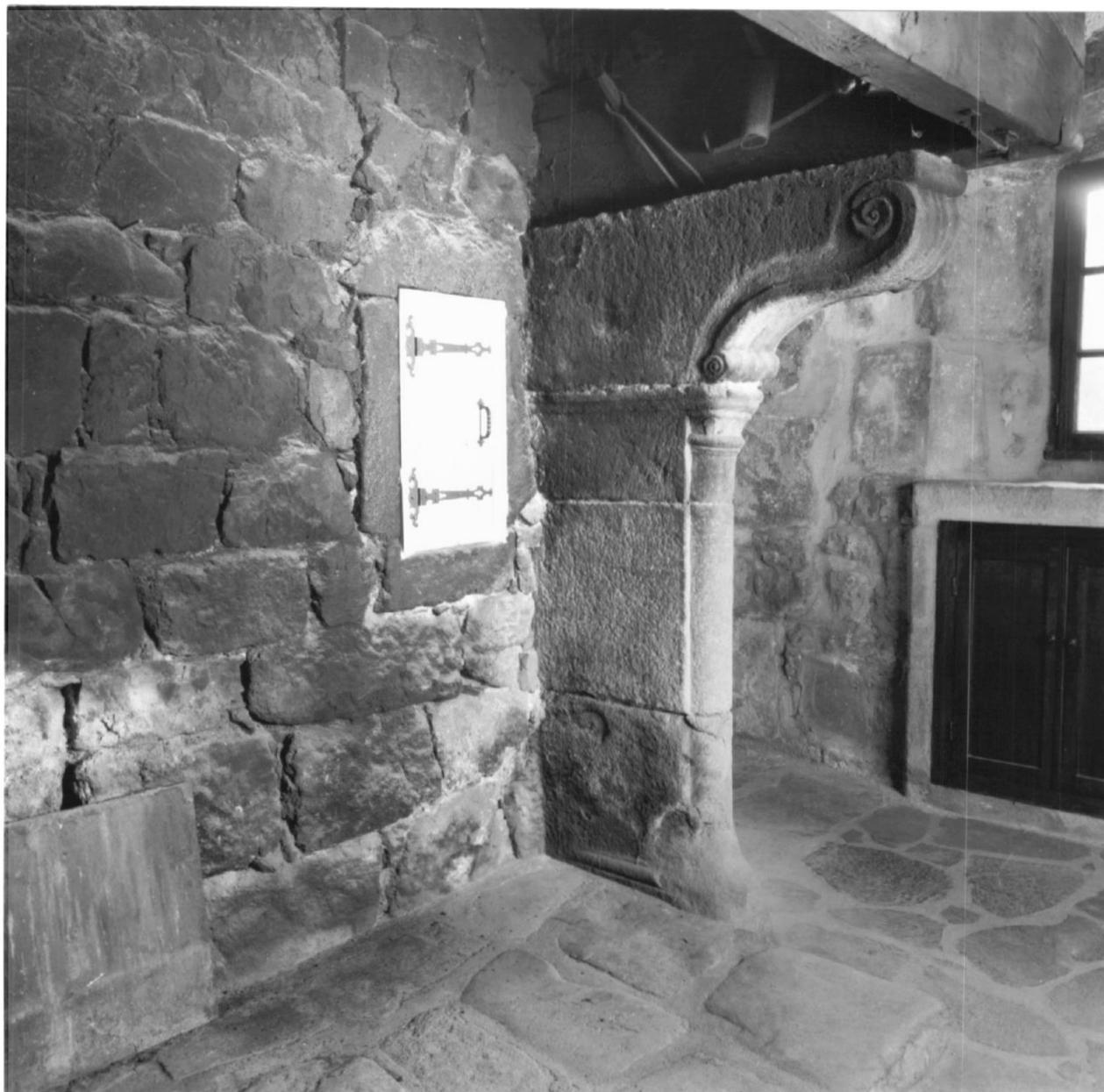
Fig. 6 Détail du four à pain de la cheminée du logis située au rez-de-chaussée surélevé.
