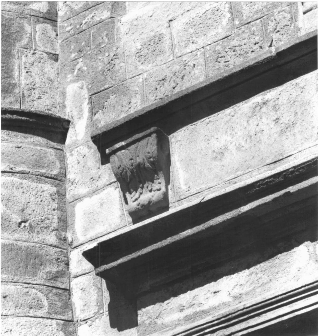
Fig. 5 Détail de la console centrale du second niveau sur la façade
