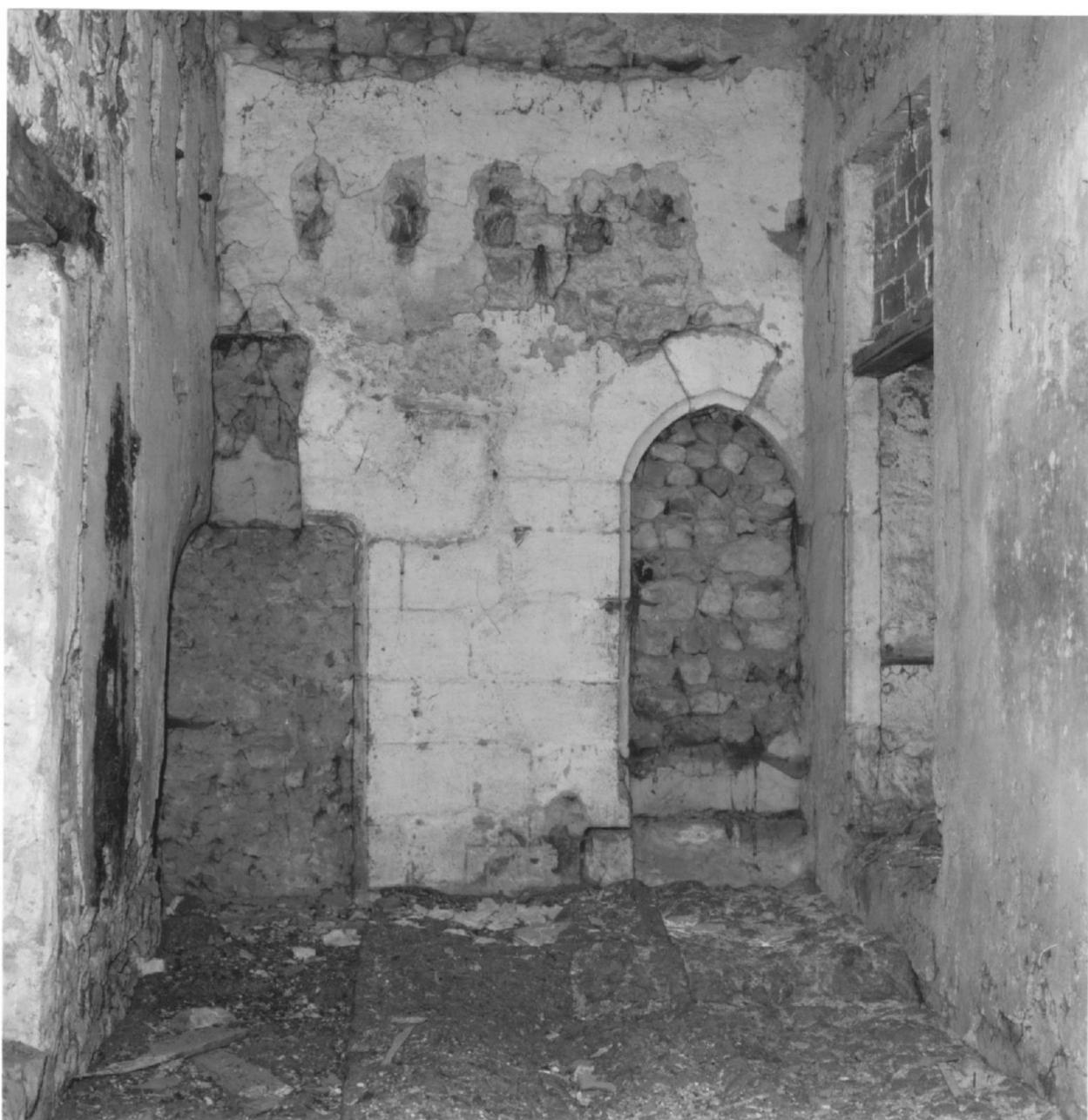
Fig. 11 Tour carrée, vestiges de la voûte d'ogives de la pièce du rez-de-chaussée, culot sud-ouest.
