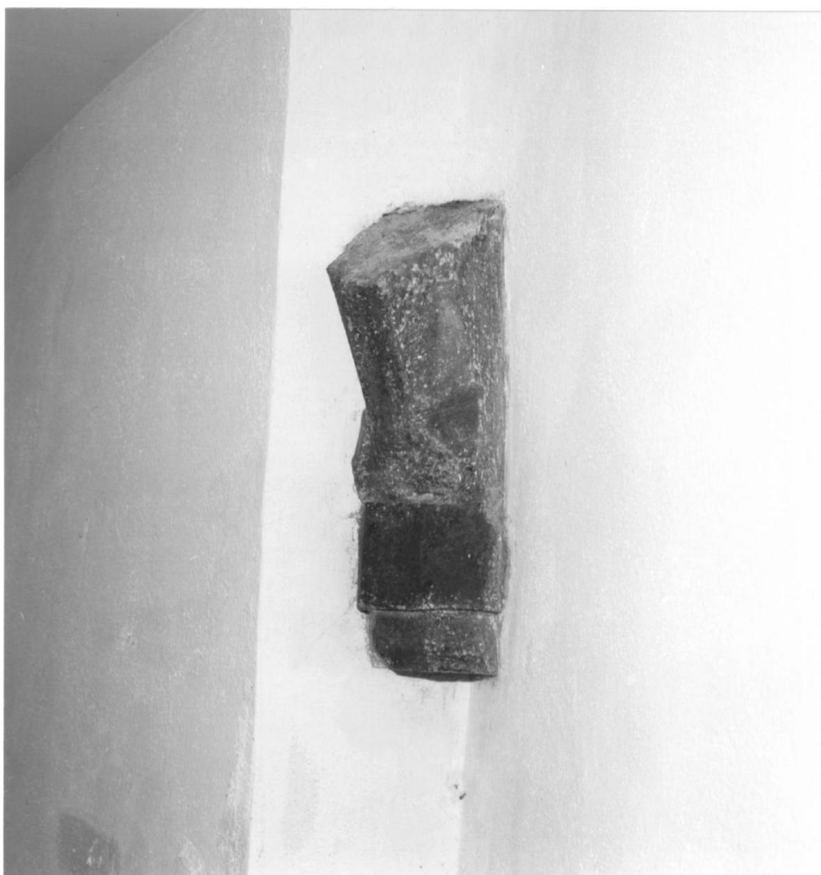
Fig. 12 Tour carrée, vestiges de la voûte d'ogives de la pièce du rez-de-chaussée, culot sud-est.
