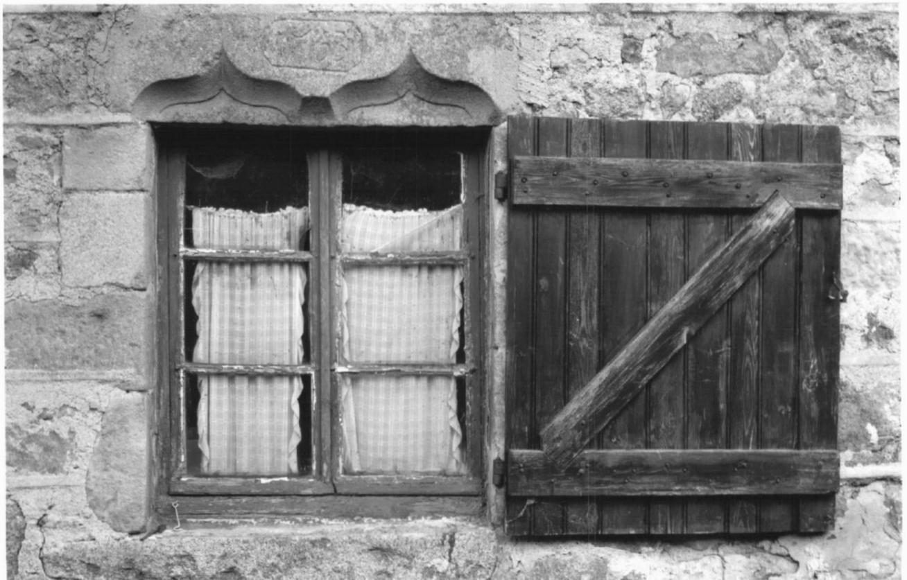
Fig. 11 Village, maison (cadastre 1986 C1 158), façade latérale sur ruelle, détail d'une baie montée avec des pierres moulurées en remploi.
