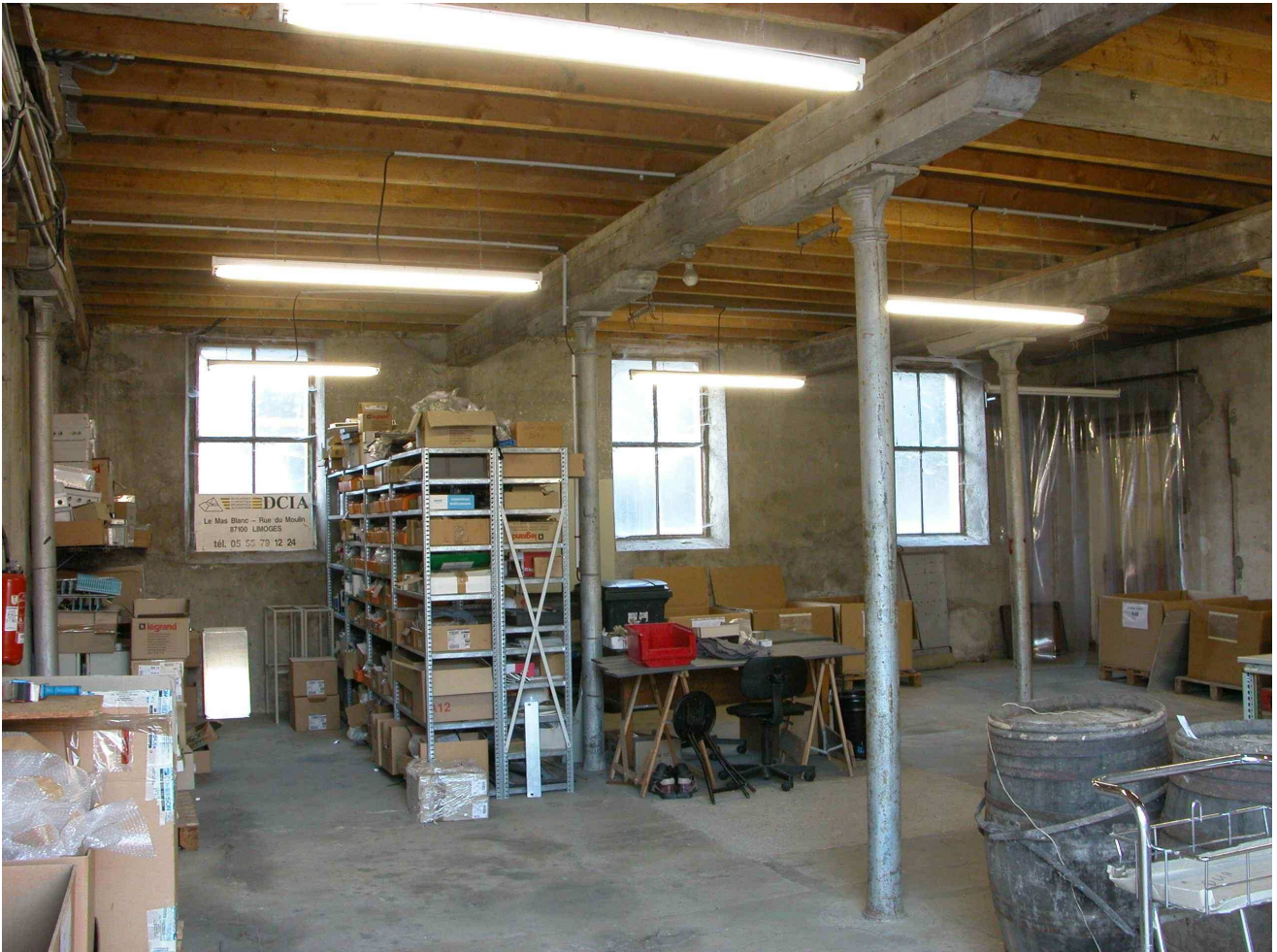
Fig.7 Rez-de-chaussée de l'ancien moulin : colonnes de fonte.
