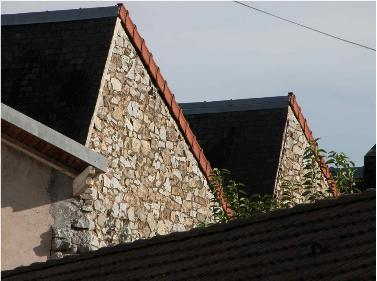
Fig.3 Toits à sheds des ateliers de l'usine construits en 1908.
