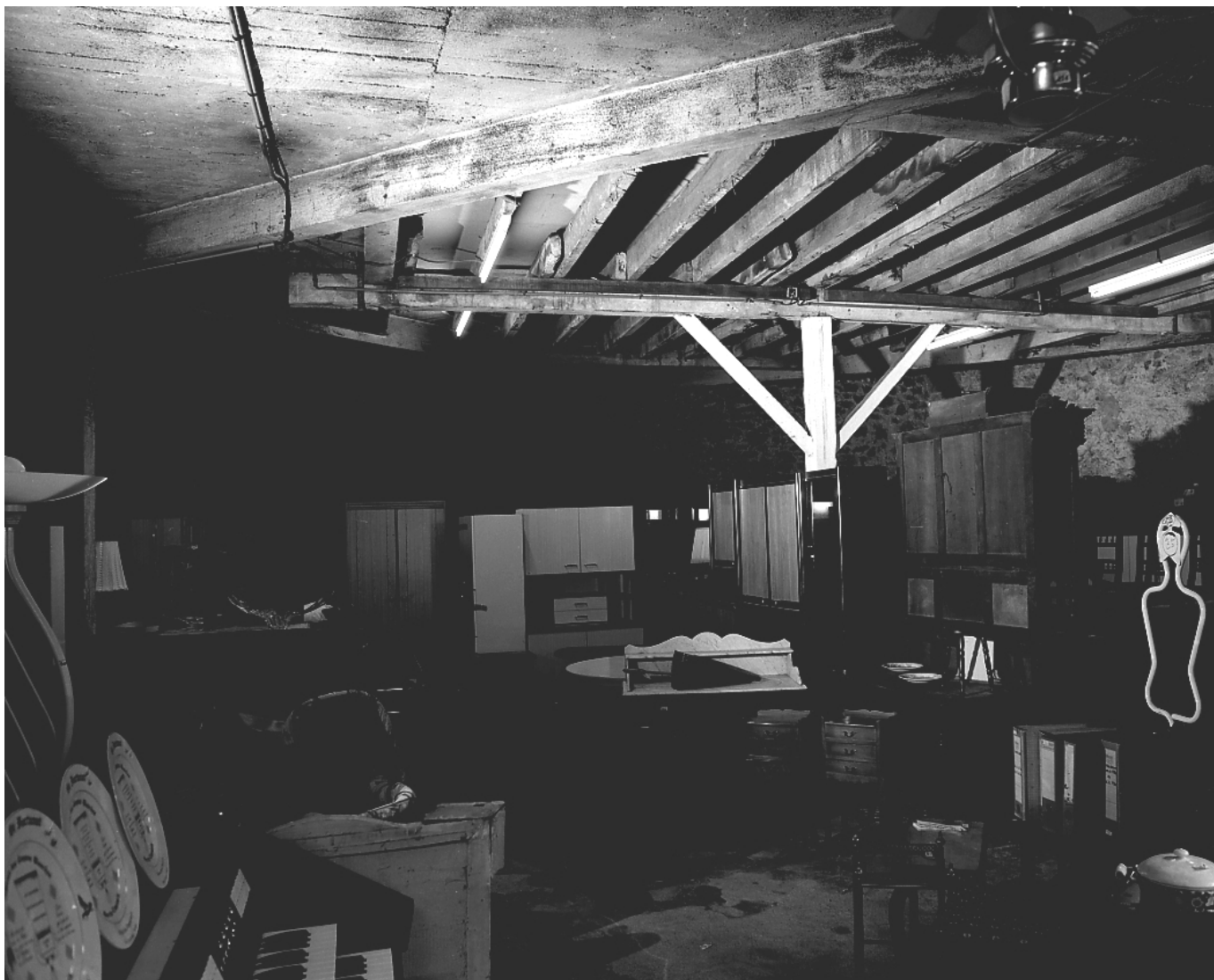
Fig.3 Le premier niveau du bâtiment du four où se situait le laboratoire et les alandiers. Le passage du four au travers du plancher est encore visible : au plancher en béton armé a été ajouté un plancher en bois soutenu par un pilier, pour combler l'orifice.
