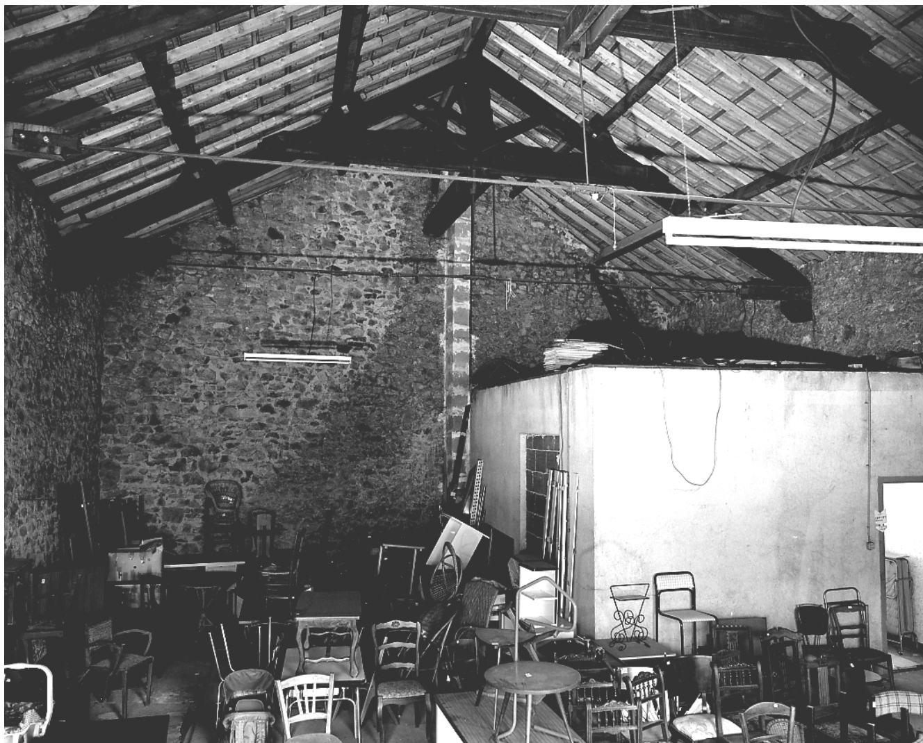
Fig.4 Le deuxième niveau du bâtiment du four, où se situait le globe pour la cuisson de dégourdi. L'entrait, proche de la voûte du globe, est remplacé par un tirant métallique. La panne de faîtage s'interrompt entre les deux fermes de la charpente, trace de l'ancien passage de la cheminée du four.
