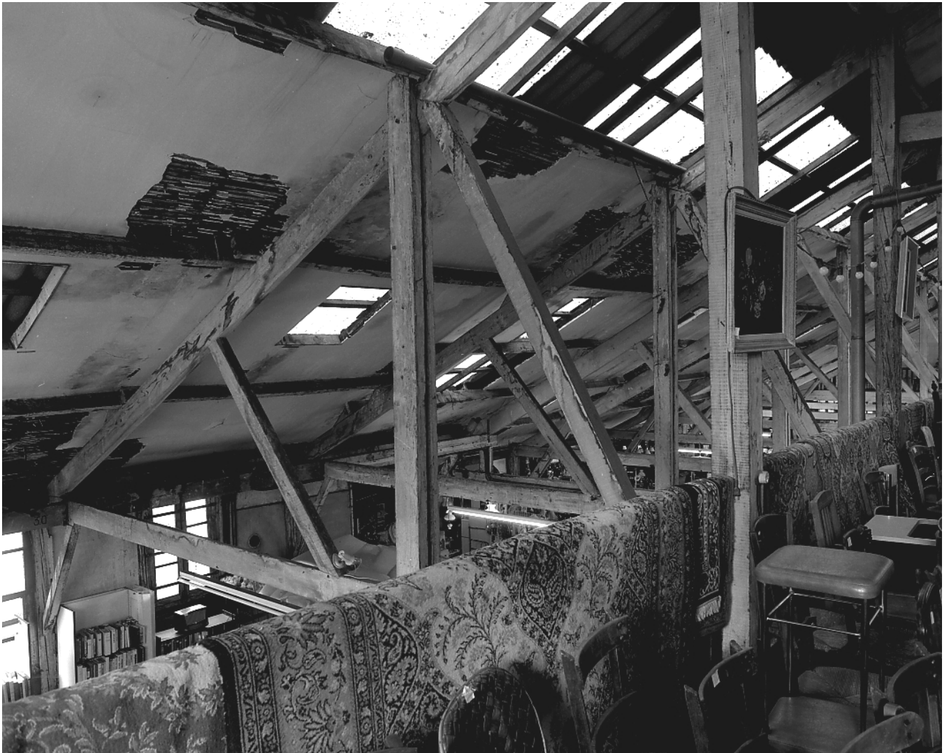
Fig.4 Les demi fermes de la partie Ouest des ateliers, vues depuis l'étage carré de la partie Est.
