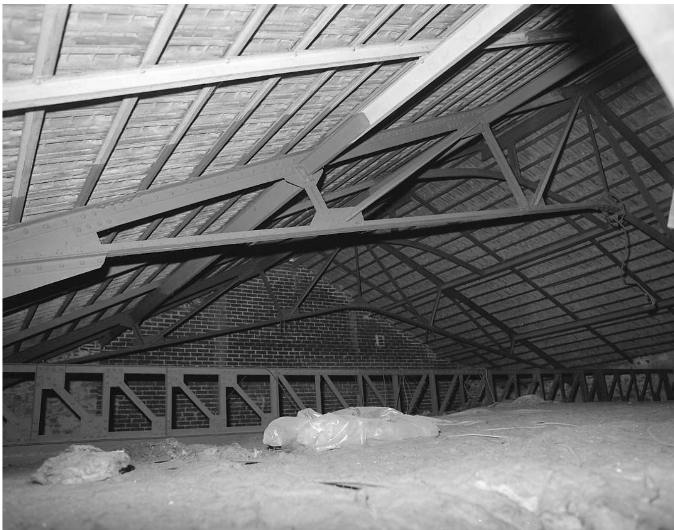
Fig.3 Charpente métallique du bâtiment du four, masquée aujourd'hui par un faux plafond. On distingue l'interruption de la panne faîtière qui permettait le passage de la cheminée du four. Subsistent des structures du lanterneau qui surmontait le globe du four.
