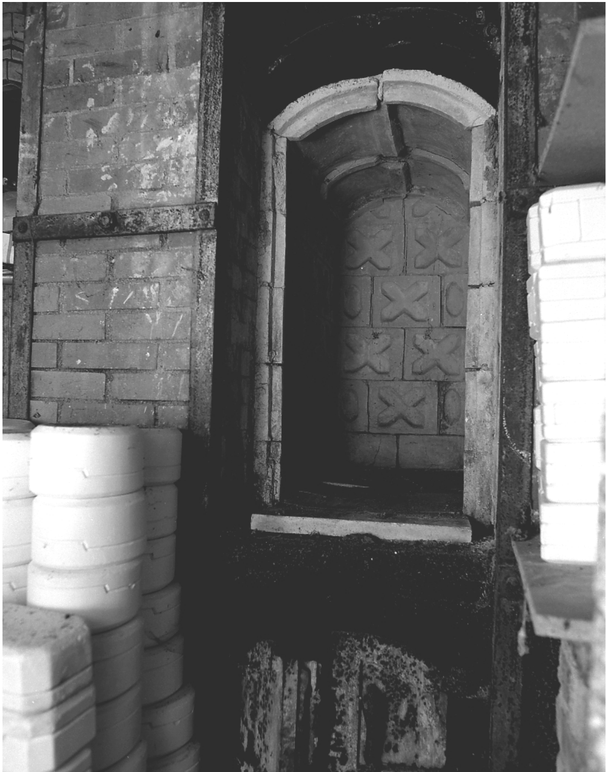
Fig.24 L'ancienne moufle (four pour la cuisson des décors) : en bas le foyer ; en haut le four proprement dit dont la voûte est abaissée et la paroi réfractaire redoublée.
