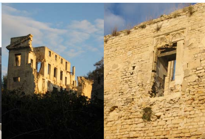
Secteur Istres/Salon-de-Provence –Martigues – Château de Ponteau – C. Martin Raffier photos©sdap13
