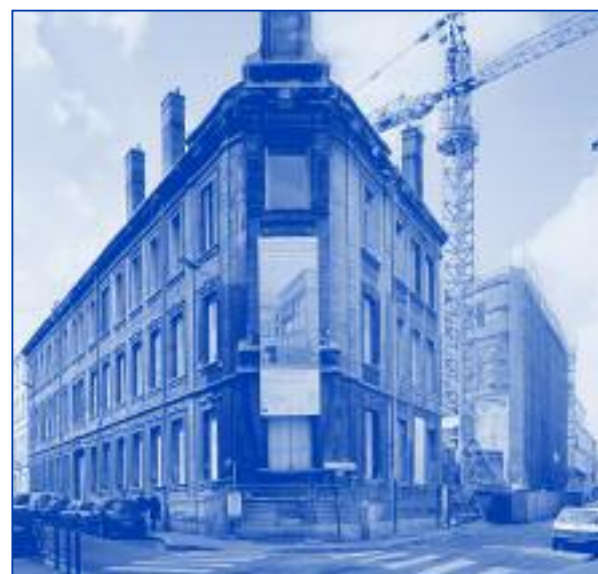
ENSA de Saint-Etienne - Pignon de la façade sud-est vue de la place Jacquard avant travaux - Photo Jean-Marie Monthiers®
