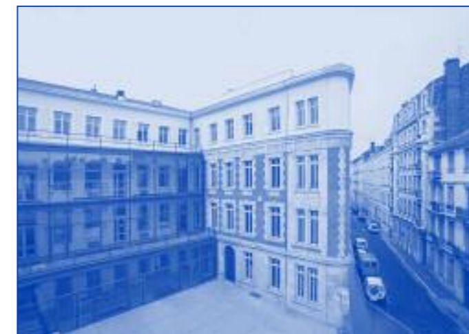
L'ENSA vue de la rue Buisson après rénovation - Pignon de la façade sud-est vue de la place Jacquard avant travaux - Photo Christophe Camus®
