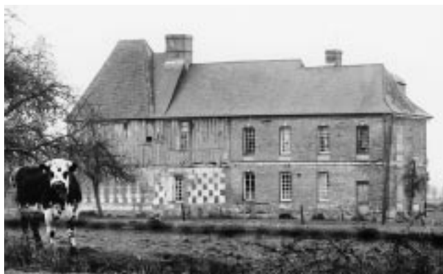
Élévation postérieure du logis (Yvon Miossec © Inventaire Haute-Normandie).
