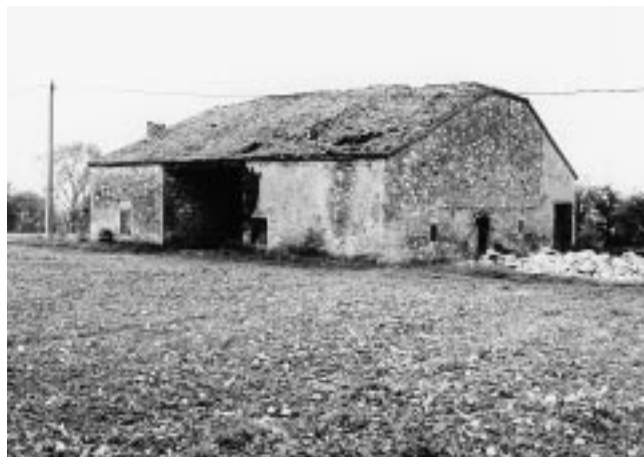
Édifice à corps de bâtiment unique abritant logis et dépendances : Montagnac-sur-Auvignon, Boy (Bernard Chabot © Inventaire Aquitaine).
