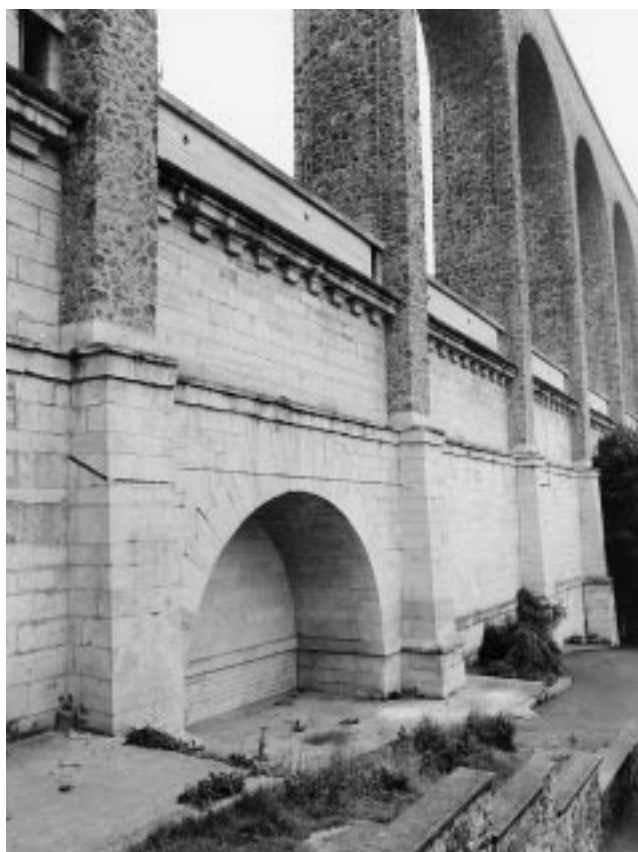
Le pont aqueduc Rungis, en pierre de taille, surmonté de celui de la Vanne en Meulière (Christian Décamps © Inventaire Ile-de-France).
