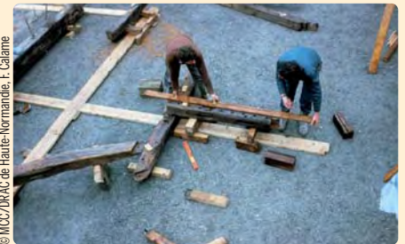
Charpentiers disposant les bois d'une ferme sur blochet au-dessus de l'épure matérialisée au sol.
