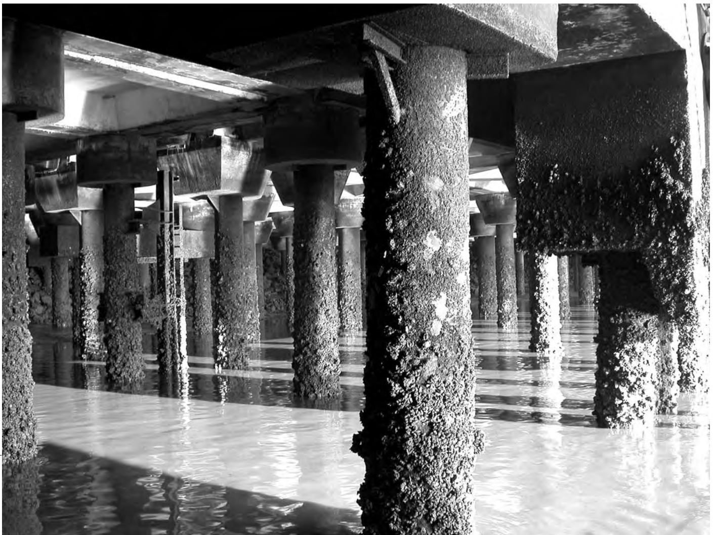
Forêt de pieux soutenant un quai : problématique du choix des pieux, de la périodicité de mesure et de la hauteur d'eau pour la mesure (marées).
