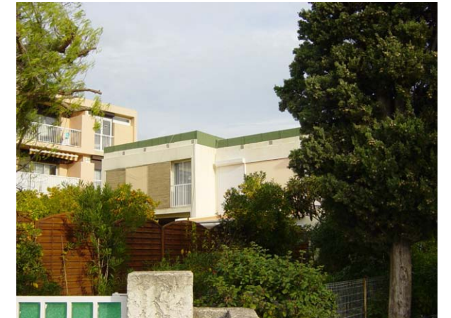
Bâtiment G : façade Ouest
