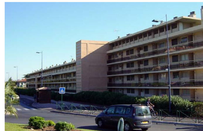
Bâtiments E et F : façade Nord
