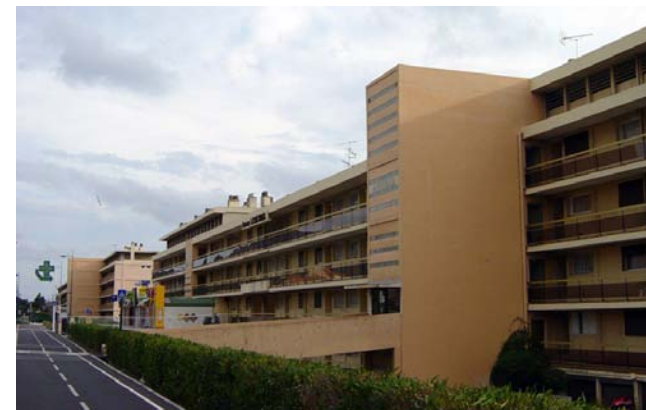
Bâtiments A et B formant barre en baïonnette : façade Nord
